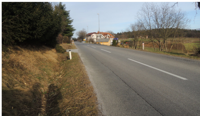
Slika 26: Nevaren cestni odsek brez pločnika na Ratežu.
